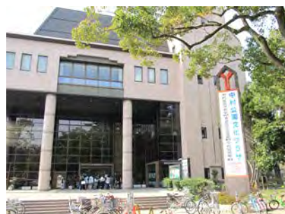
中村公園文化プラザ外観
