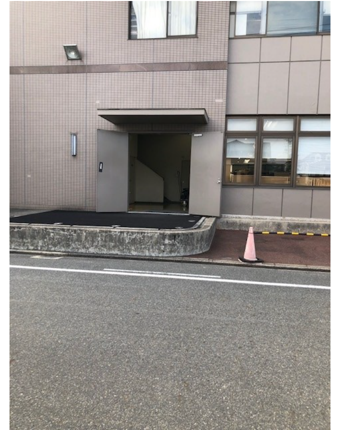
②搬入口開口
