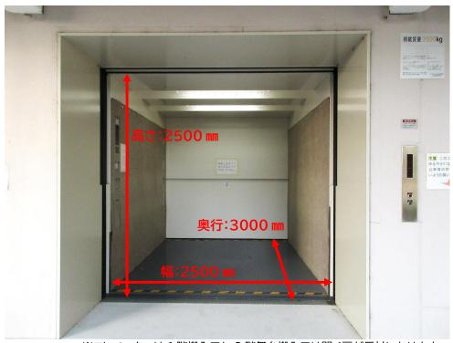
※エレベーターは 1 階搬入口と 2 階舞台搬入口は開く扉が反対になります。 積載質量 2500 kg
