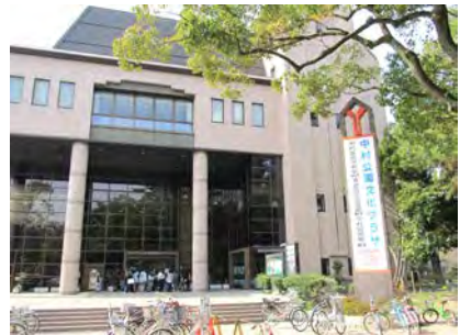
中村公園文化プラザ外観
