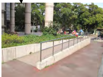
駐車場側スロープ
