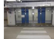
エレベーター
